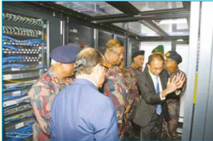
বিজিবি ডাটা সেন্টারের বিভিন্ন দিক পরিদর্শন করেন মাননীয় মহাপরিচালক, বিজিবি
